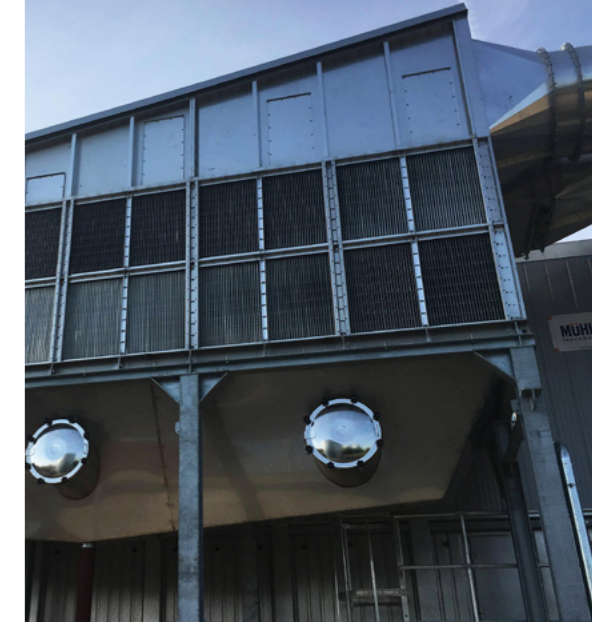
Mit dem Wärmerückgewinnungssystem lassen sich bis zu 50 % thermische Energie einsparen
